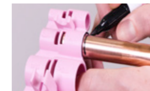
7a. Markeer de insteekdiepte op de buis met behulp van een dieptemeter
